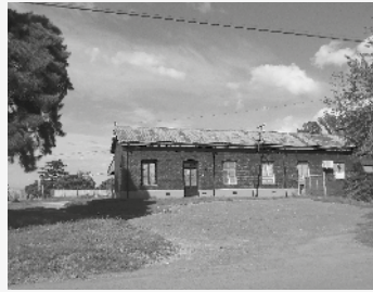
Cuadro de Estación General Lagos Bodegas sobre la barranca
